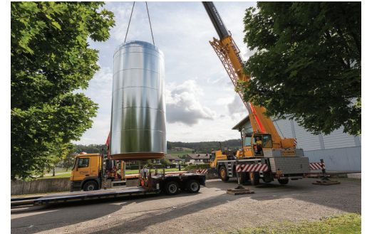
Der neue Wärmespeicher wird eingeliefert.
