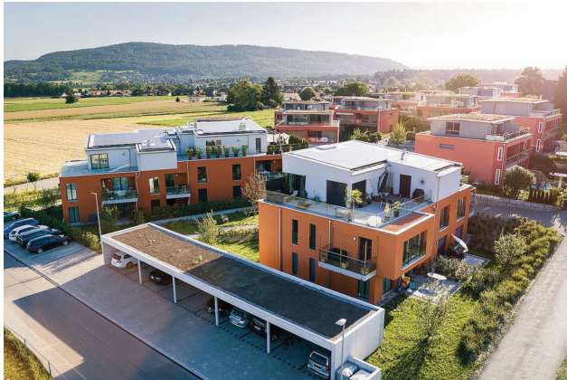
Solaranlage auf den Dächern der beiden Häuser.
