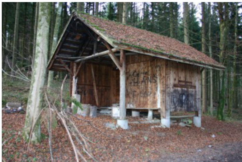
Reservehütte im Korporationwald
